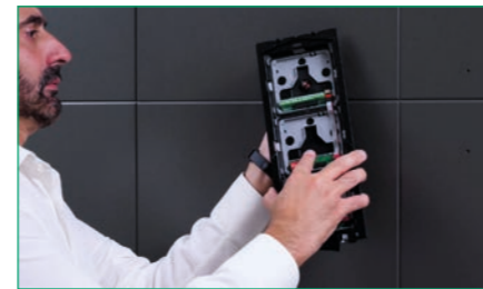
4. POSITIONIEREN Sie die Türstation an der Wand, führen Sie die Versorgungsdrähte in die vorgesehene Aufnahme und befestigen Sie diese mit den beiden oben und unten befindlichen Schrauben
