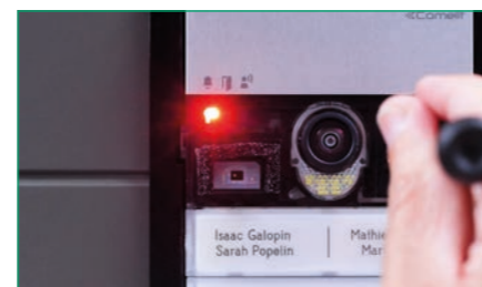
9. RUFEN SIE MIT dem vorgesehenen Wahlschalter den Programmiermodus auf (dies wird durch das Aufleuchten der LED angezeigt) und wählen Sie MITTELS DIP-Schalter die erste Adresse, die der ersten Taste zugewiesen wird
